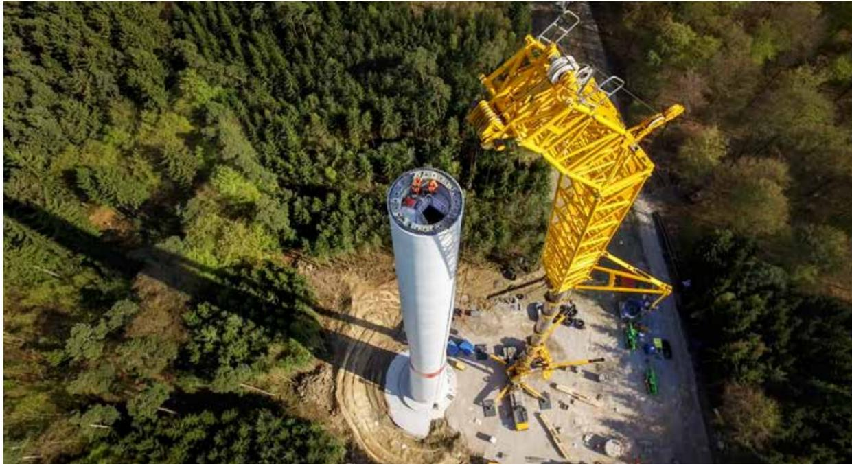
Mit Hilfe eines gigantischen Mobilkrans wird der Hybridturm System Max Bögl errichtet.
